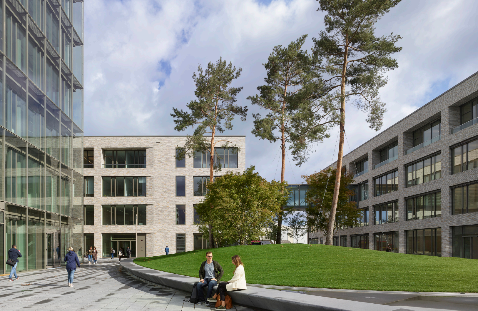
Hochschule Heilbronn (HHN), Gebäude S und T
