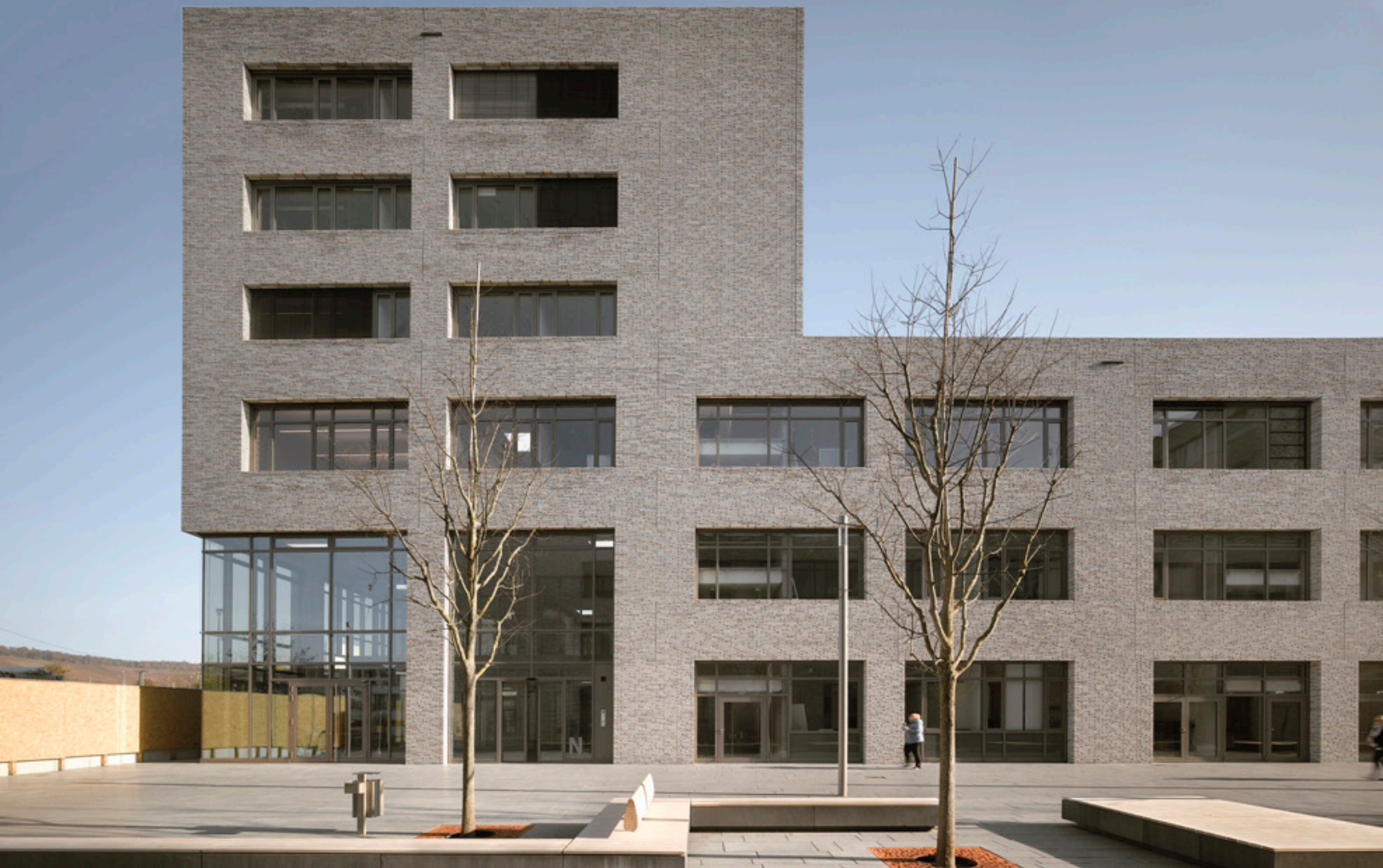
Hochschule Heilbronn (HHN), Gebäude N
